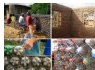
Рисунок 2 - пример использования пластиковых бутылок в строительстве
