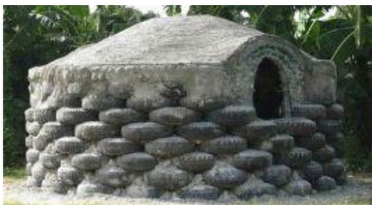
Рисунок 1 - жилой дом, построенный с использованием автомобильных шин
