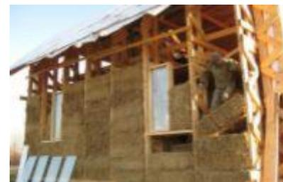
*Рисунок 4 - соломенные блоки в строительстве малоэтажного жилого дома*
